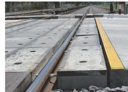
DETALLE BULÓN (encuentro losas y durmiente)
