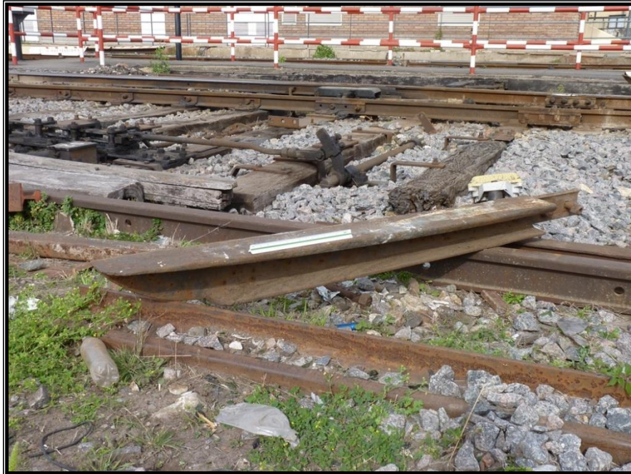
Foto 1. Rampa sin cubierta
