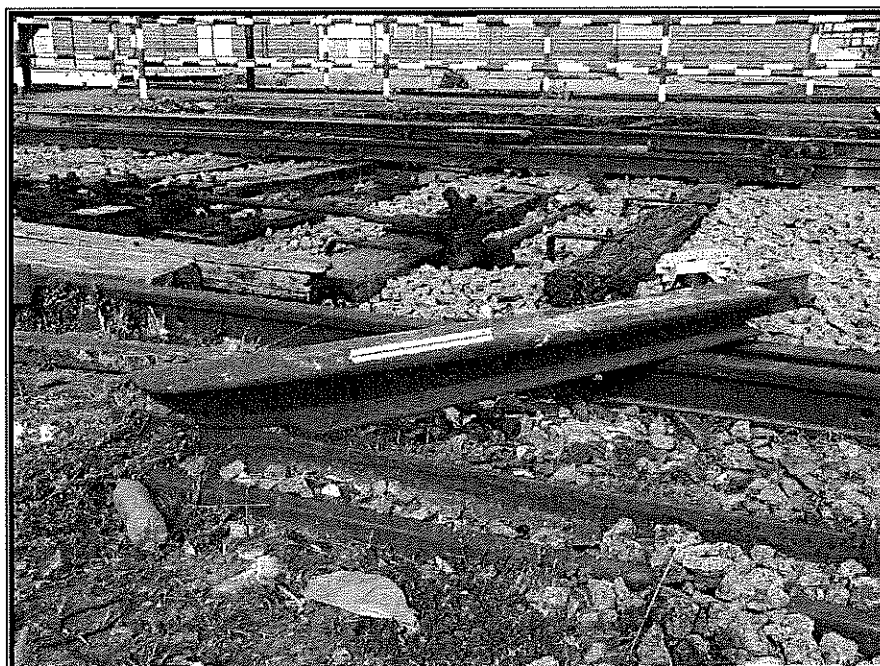
Foto 1. Rampa sin cubierta
