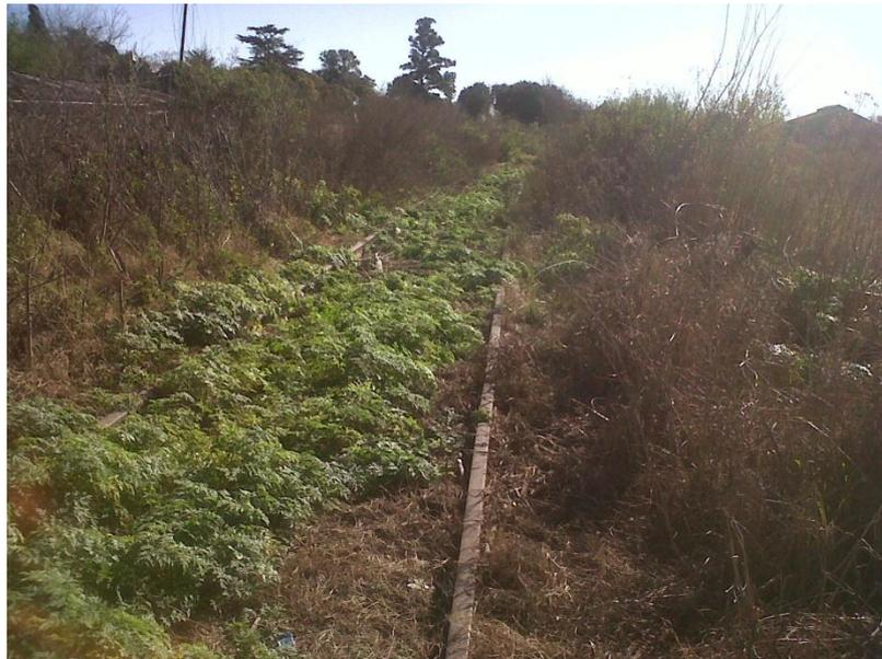
La limpieza de la zona de vía implica el desmonte, desmalezado y retiro de todo elemento extraño o residuo en la superficie que se encuentre dentro del ancho operativo de la traza del Ferrocarril Mitre (en todo el sector de Obra). En los Pasos a Nivel, la superficie a limpiar se extenderá a todo el rombo de visibilidad. Según Resolución SETOP 7/81 “NORMAS PARA CRUCES ENTRE CAMINOS Y VÍAS”.
