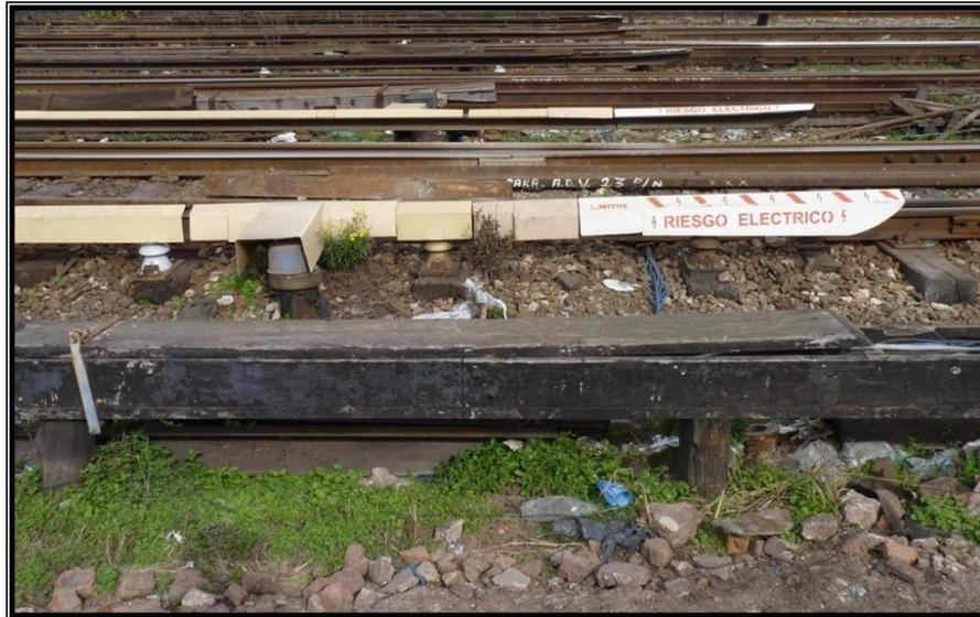
**Foto 4.** Tramo con aislador de soporte, acometida de cables desde subestación y rampa
