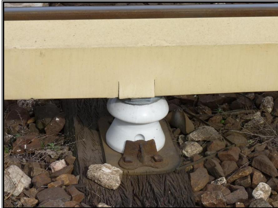
**Foto 6. Aislador soporte instalado en durmiente de madera**
