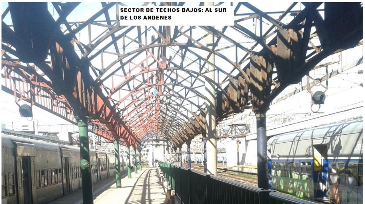
Para esta tarea se colocarán paneles de chapa acanalada de acero revestido CINCALUM espesor calibre C22 marca TERNIUM- SIDERAR, en cumplimiento con la Norma **IRAM-IAS U 500-204**. No se aceptará otra marca, ni calidad del material.
