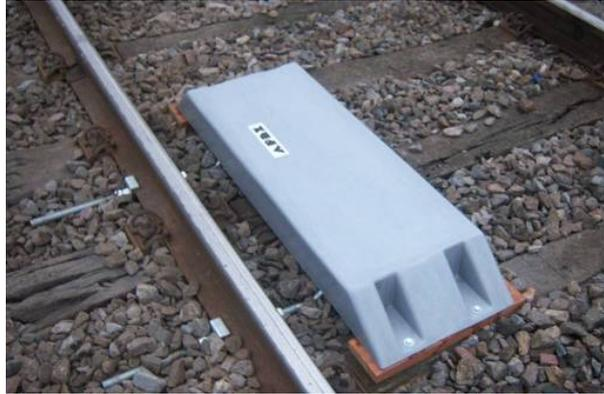
**Ensayos:** Las mediciones de las bobinas terrestres se realizarán mensualmente una vez realizada su instalación en vía hasta la recepción definitiva. A cargo de la contratista.
