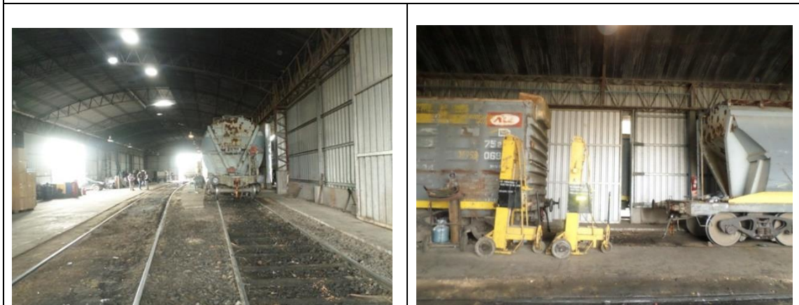
IMÁGENES 4 Y 5: FALTA DE VENTILACIÓN FORZADA E ILUMINACIÓN.
