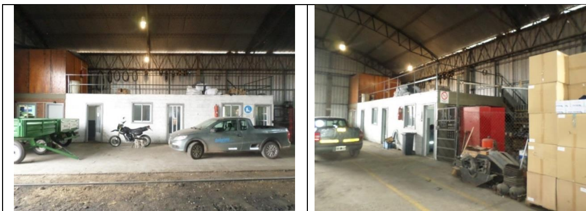
IMÁGENES 6 Y 7: CONSTRUCCIÓN DE NUEVAS OFICINAS EN TALLER GENERAL.
