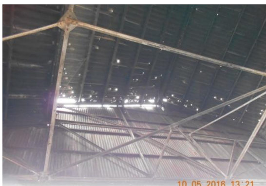
IMÁGENES 7 Y 8: CUBIERTA A RENOVAR, LATERAL Y VIDRIOS A REEMPLAZAR.
