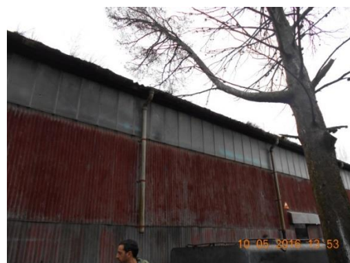
IMÁGENES 7 Y 8: CUBIERTA A RENOVAR, LATERAL Y VIDRIOS A REEMPLAZAR.
